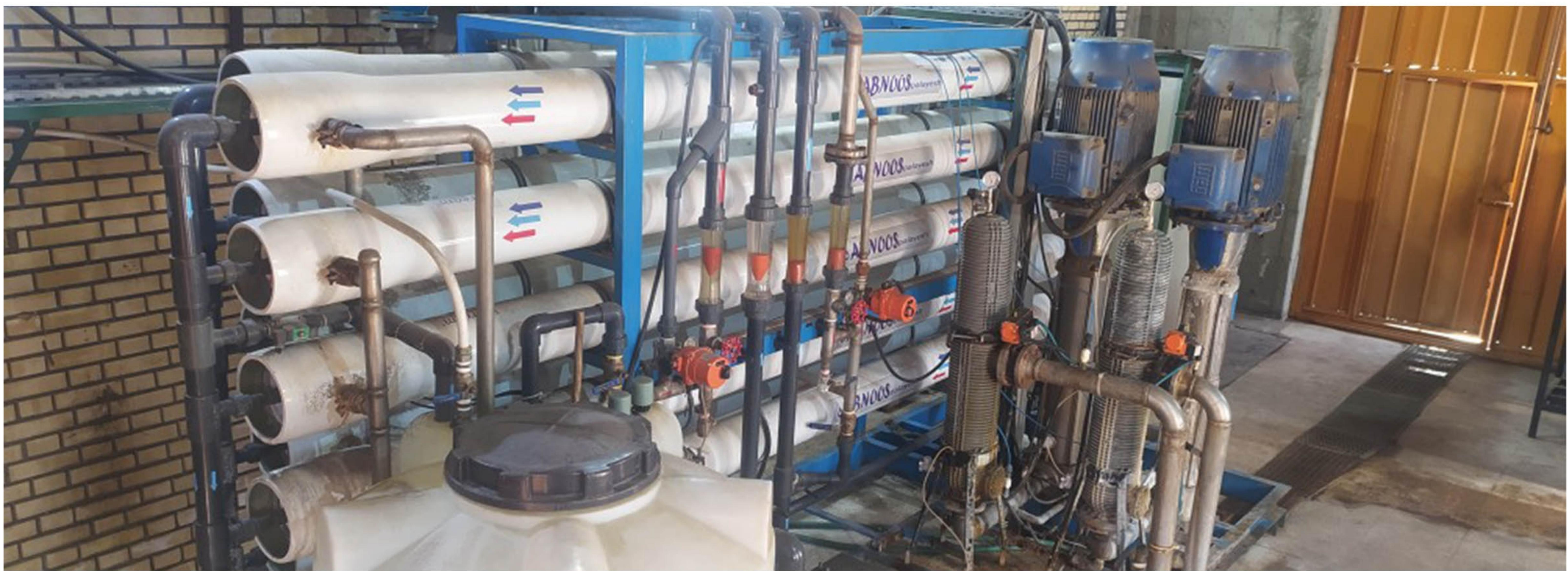
از مشکلات اجتناب ناپذیر که کلیه صنایع با آن روبرو می‌شوند میتوان به پدیده خوردگی و رسوب گذاری آب اشاره کرد که به ترتیب باعث تخریب فلزات و کاهش جذب حرارت گرمای حاصله و در نتیجه افزایش هزینه‌های غیر مستقیم تولید می‌شود.
